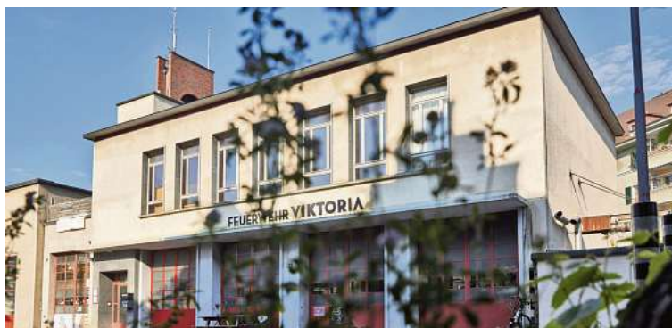
Saalbau an der Gotthelfstrasse, der in den Innenhof verschoben und umgenutzt werden wird.
