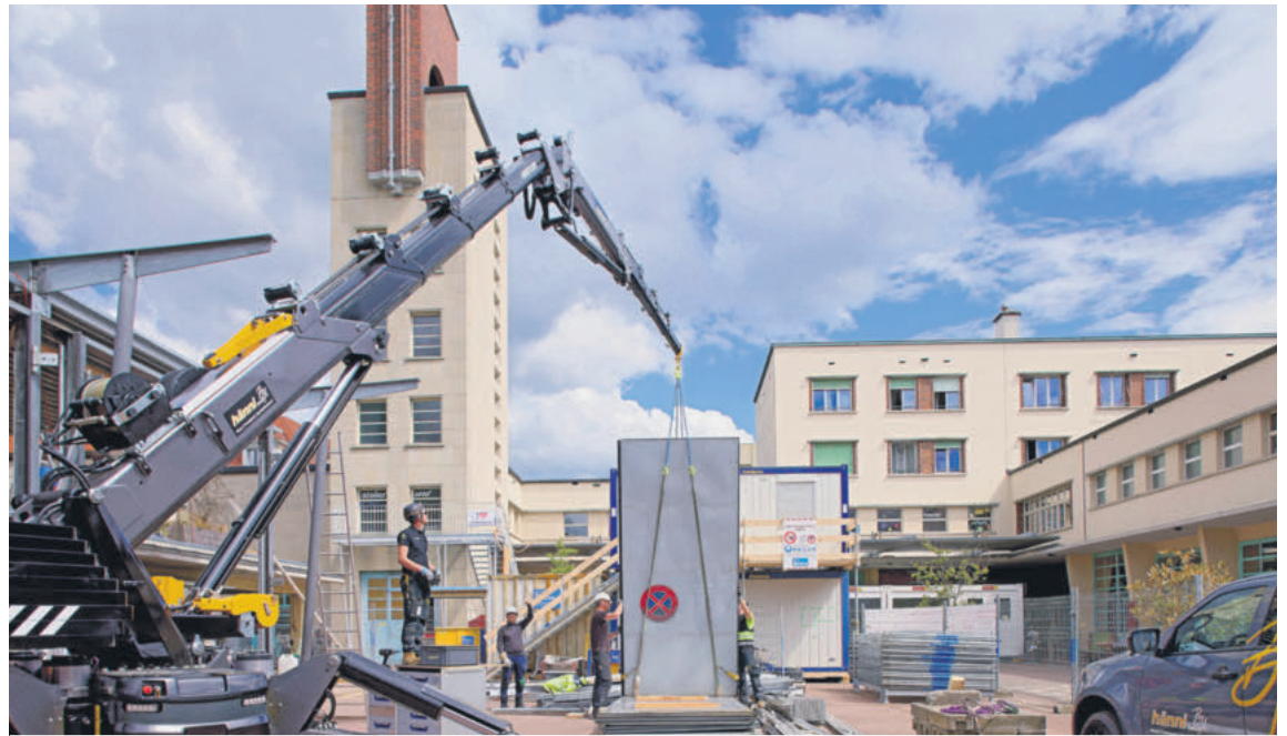
Für die Translozierung des Saalbaus an der Gotthelfstrasse musste viel aufwändige und anspruchsvolle Vorbereitungsarbeit geleistet werden.
